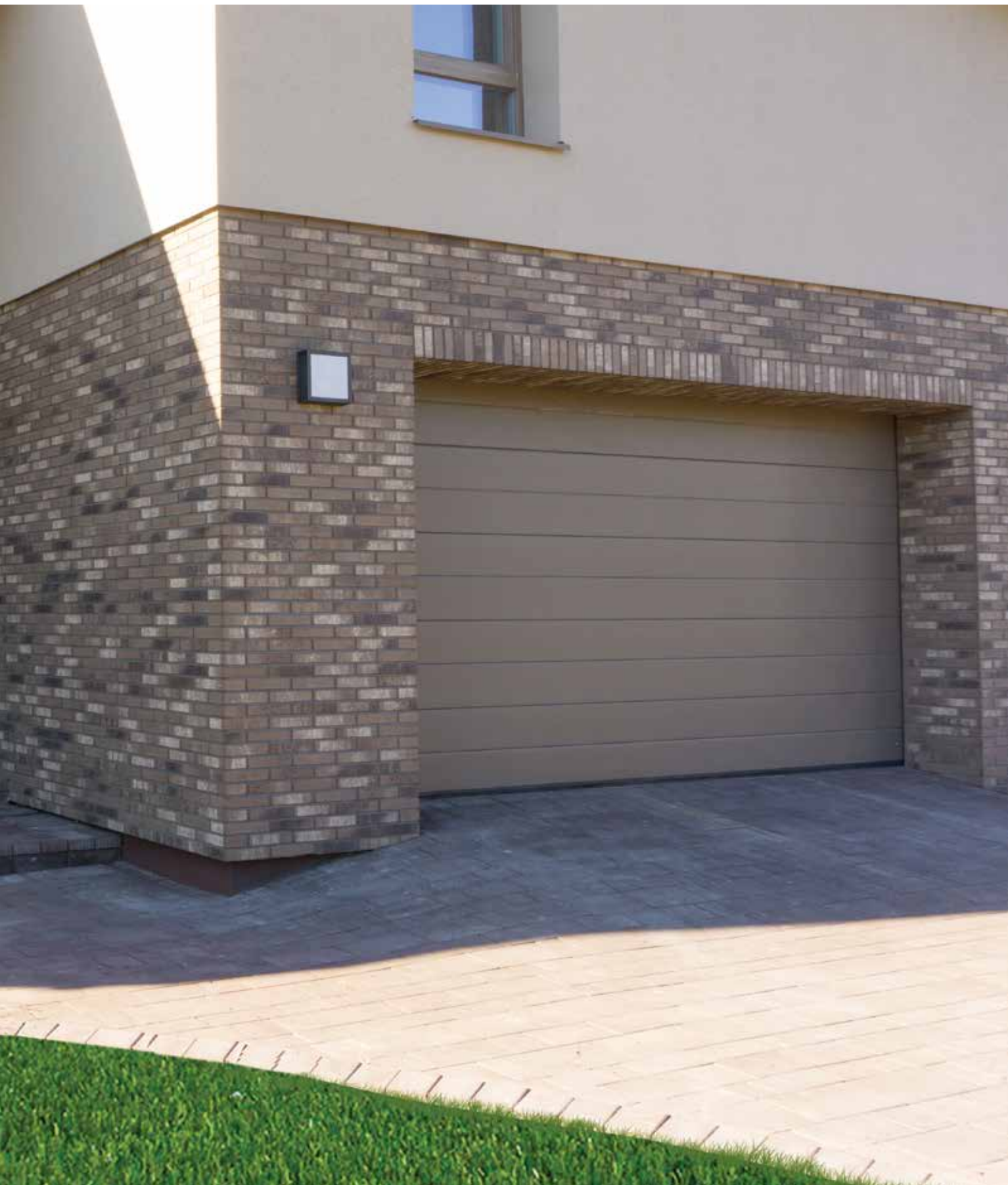
Portes d'entrée correspondante à porte de garage.
