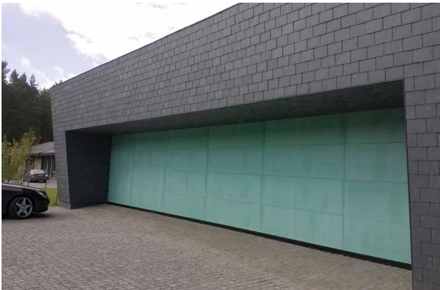
Porte de garage sectionnelle de 11 mètres de large revêtue par tôle vert-cuivre.
